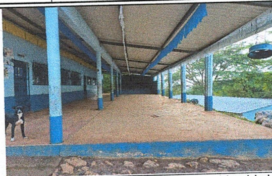
Foto 14: Colocación de celosía el contorno del corredor del modulo de la escuela.
